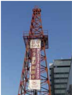
▲温泉掘削のために組まれた塔
