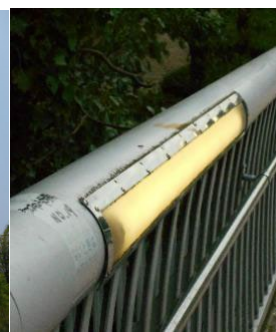
歩道橋の蛍光灯(No.19) 全て1灯式
