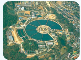
上ヶ原浄水場(西宮市) (浄水能力:7.0万m 3 /日)
