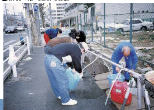
■耐震化された管に仮設給水栓を設置
