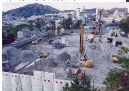
会下山低層配水池本格復旧工事
