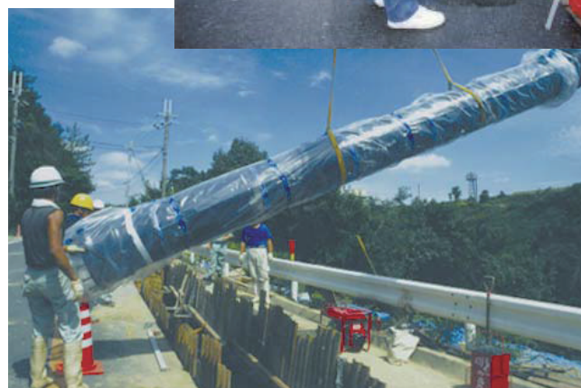
■耐震継手管の施工状況
