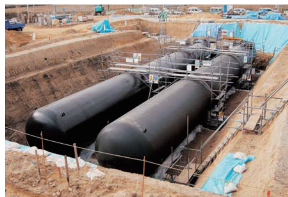
■大容量貯水槽の施工状況
