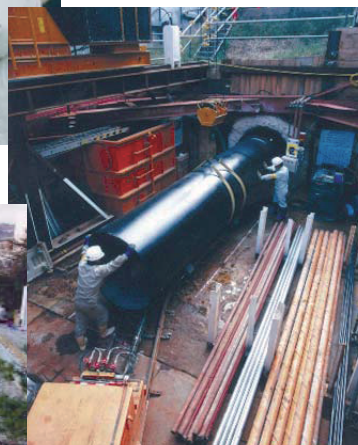
千刈導水路本格復旧工事 (パイプ・イン・トンネル工法)
